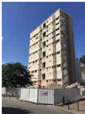
Fin de démolition du 19 Cannes
