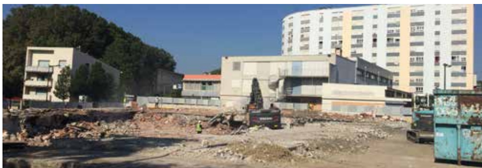
Démolition du centre commercial Casino
