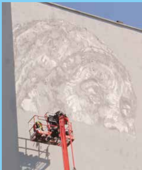
ECB en plein travail sur une façade d'Empalot
