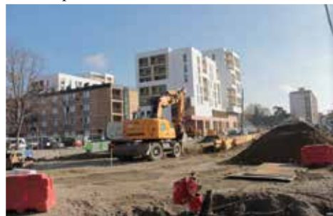
Travaux aménagement rue Mombiola.
