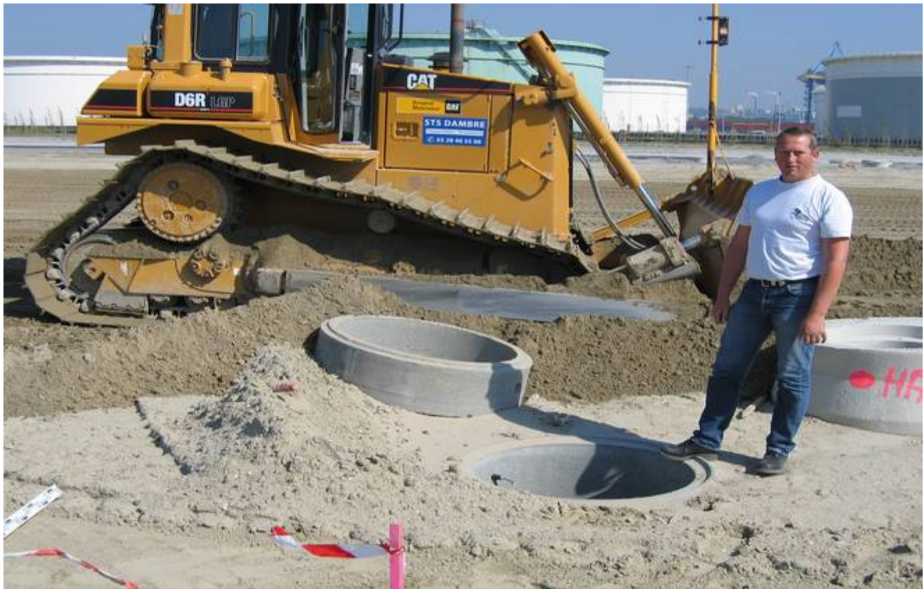
Réglage au Bull avec Laser avant nivellement à la côte finale
