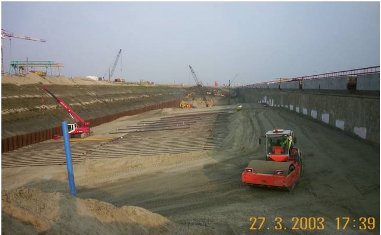
Remblai en sable sur les tirants et pose des tirants supérieurs
