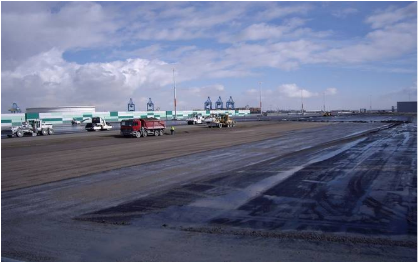
Plate-forme en sable livrée avec pente de 2% et mis en œuvre de grave traitée
