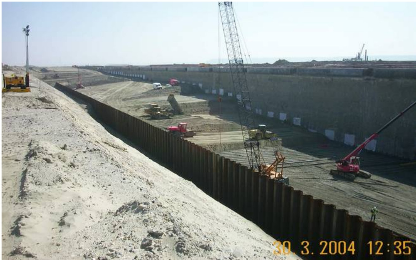
Remblai en sable sur les tirants et pose des tirants supérieurs
