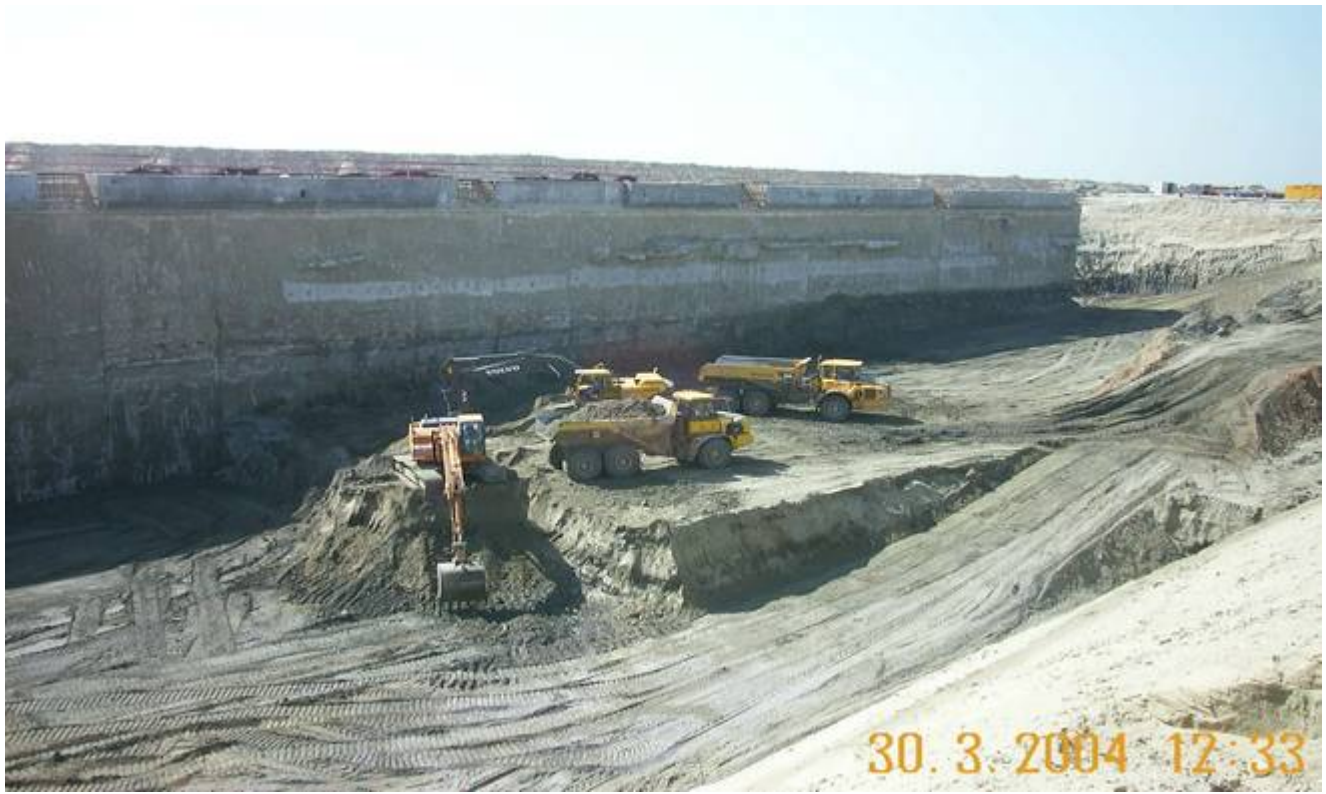
Terrassement à la cote -7.5 CMH pour la pose des palplanches et des tirants inférieurs.
