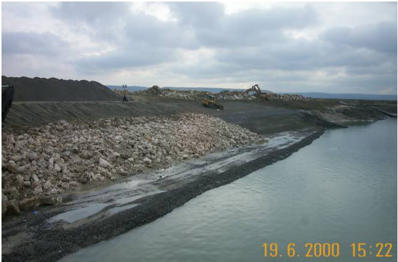
Talus en fond de darse en calcaire avant pose des enrochements.
